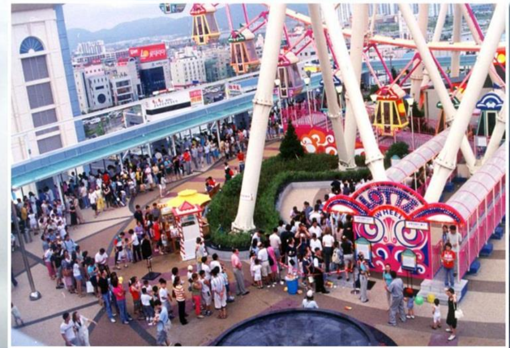
Колесо обозрения 80 м на крыше здания высотой 40 м в Ульсане, Юж. Корея, возведенное в 2001 году совместно с корпорацией Lotte.
